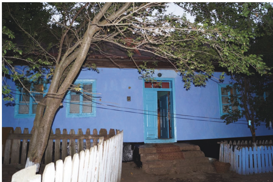
Fot. 30. Budynek dawnej szkoły polskiej w Bulaju, 2017
