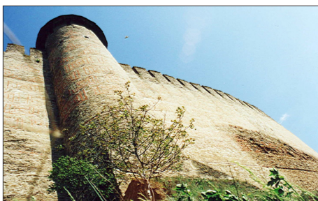
Potęża zachodniej części murów zamku w Chocimiu wraz z Basztą Komendancką. Stan z sierpnia 2002 r. (fot. Aleksander Smoliński)
