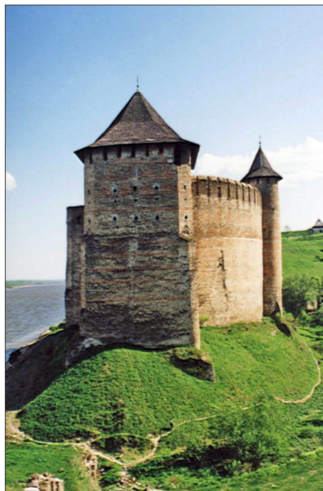
Północna część zamku. Widoczna Baszta Północna – donżon, czyli ogromna wieża refugialna. Stan z sierpnia 2002 r. (fot. Aleksander Smoliński)
