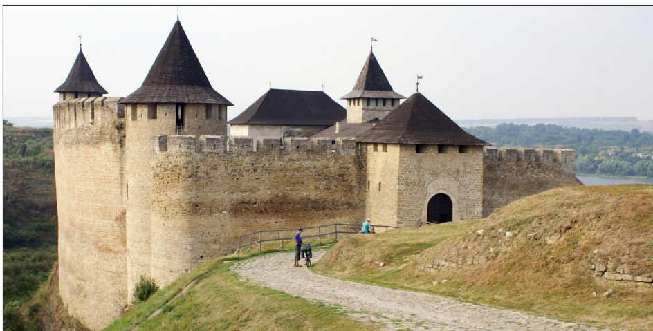
Widok od strony południowej i zachodniej na zamek chocimski. Częściowo widoczne są Baszty Południowo-Zachodnia, Komendancka oraz Baszty Bramna i Wschodnia, a także dach kaplicy zamkowej. Stan z sierpnia 2013 r. (fot. Aleksander Smoliński)
