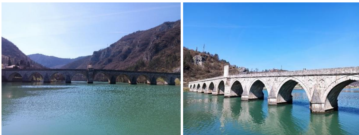
Il. 1 i 2. Most na Drinie w Višegradzie. Fot. Marzena Maciulewicz, 2024.
