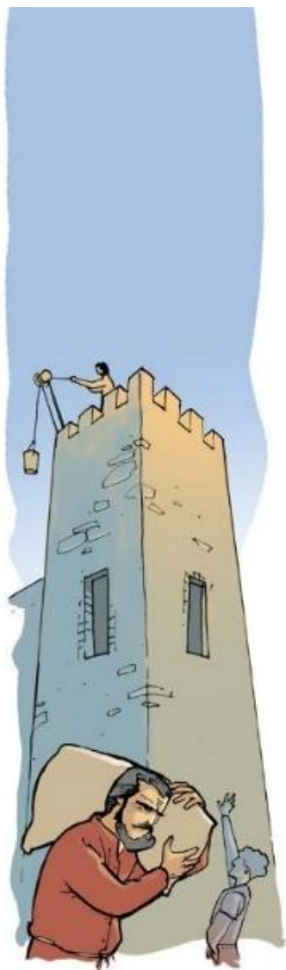
Il. 15. Jovan Ukropina, Zidanje Skadra .
